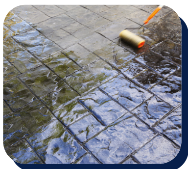
PROTECCIÓN Y REPARACIÓN
