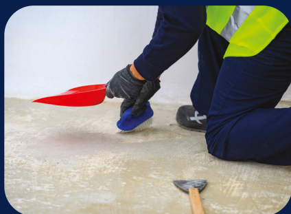
PASO 1 Preparación de la superficie
