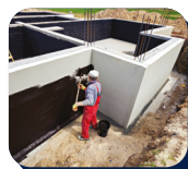
Cimentación y muros de contención
