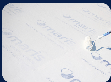
PASO 7 Segunda capa de la membrana impermeabilizante
