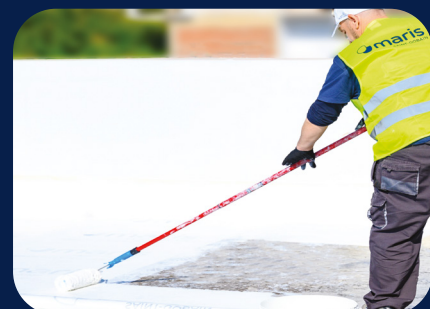
PASO 6 Refuerzo y primera capa de la membrana impermeabilizante
