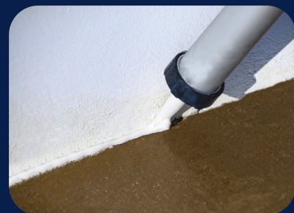
PASO 3 Reparación de grietas y juntas
