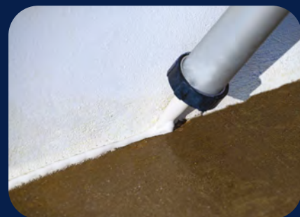
ΒΗΜΑ 3 Επισκευή και σφράγιση ρωγμών και αρμών
